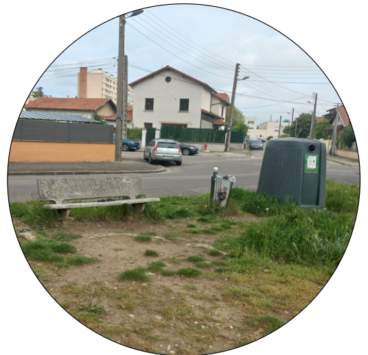
UN MOBILIER EN MAUVAIS ETAT ET UN ESPACE VERRE PEU INTEGRE
